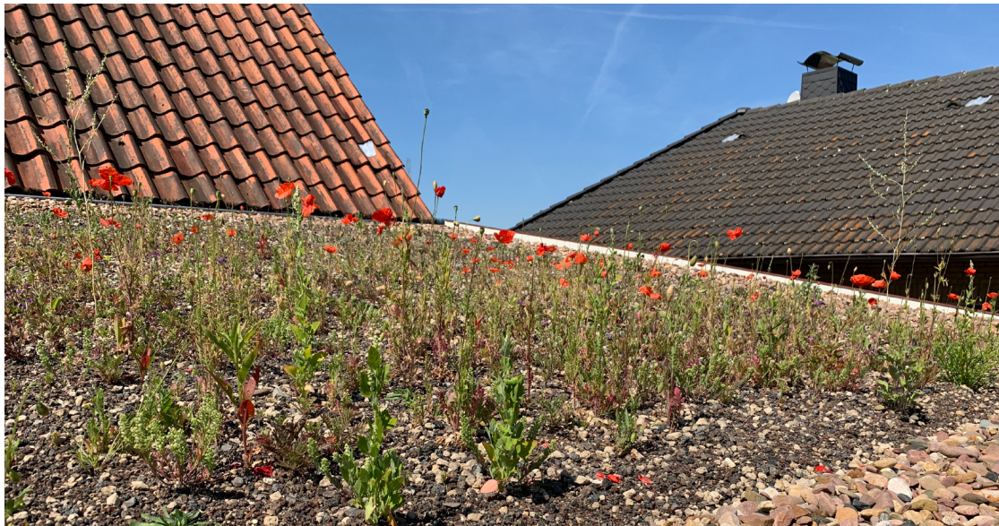
Abbildung 1: Dachbegrünung Schrägdach. Foto: Kreis Minden-Lübbecke
